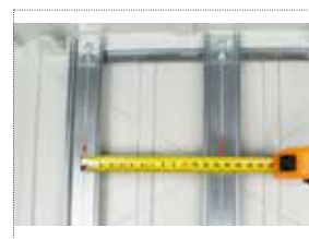
Расстояние 135 мм между DIN-рейками
